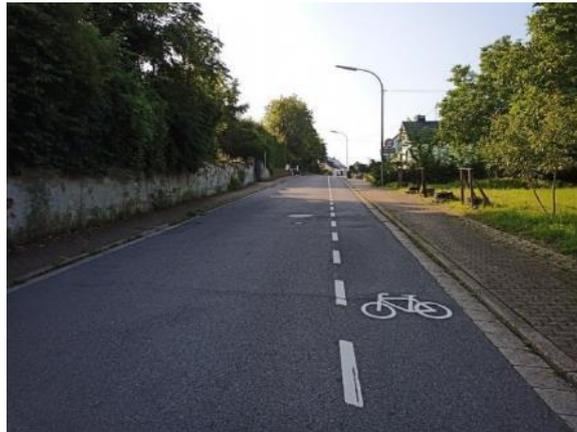
**Abb. 19 Prinzipskizze eines alternierenden Schutzstreifens**
